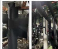
2023.1 브라인 배관 도입 [투자효과] 브라인배관 방냉 손실 개선으로 에너지 절감 / 온실가스 감축
