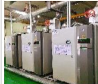
2023.3 고효율 권회설 보일러 도입 [투자효과] 기존 수관식에서 관류식 보일러로 교체함으로써 에너지 절감 / 온실가스 감축
