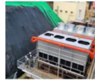
2023.1 고효율 Eva-Con 설치 [투자효과] 고효율 Eva-Con 설치로 에너지 효율 증대
